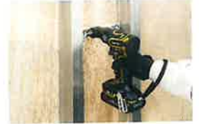
アングルアタッチメント使用
