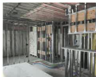
通電前の屋内作業に
