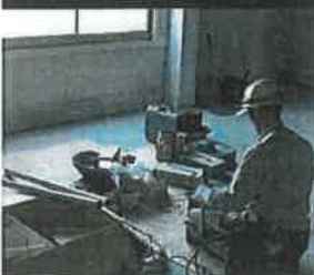
通電前の内装工事
