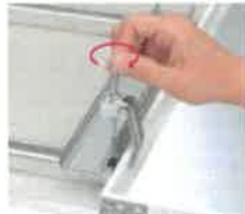
③ハンガーボルトを数回回し締めつけ固定
