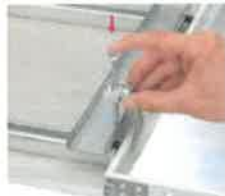
②ハンガーボルトを取付野縁に当たるところまで押し込む
